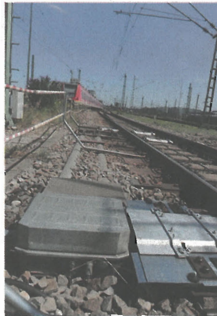
Die Weichen an der Stammstrecke haben neue Abdeckungen bekommen. FOTO: RUMPF.
